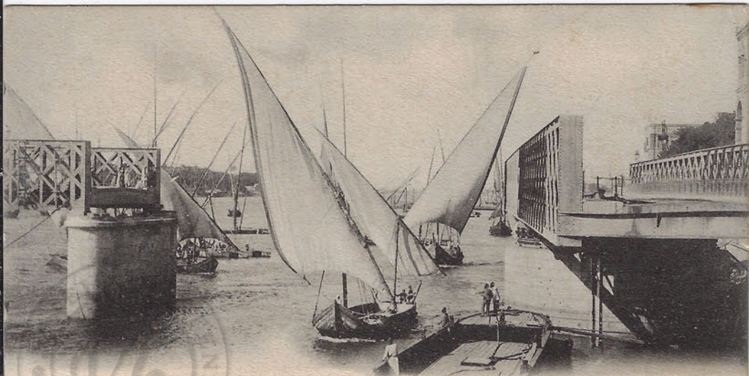
Le Pont de Gesirah ouvert.
