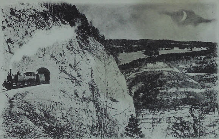
Chemin de fer Yverdon — Ste. Croix: Tunnel de Covatannaz.
