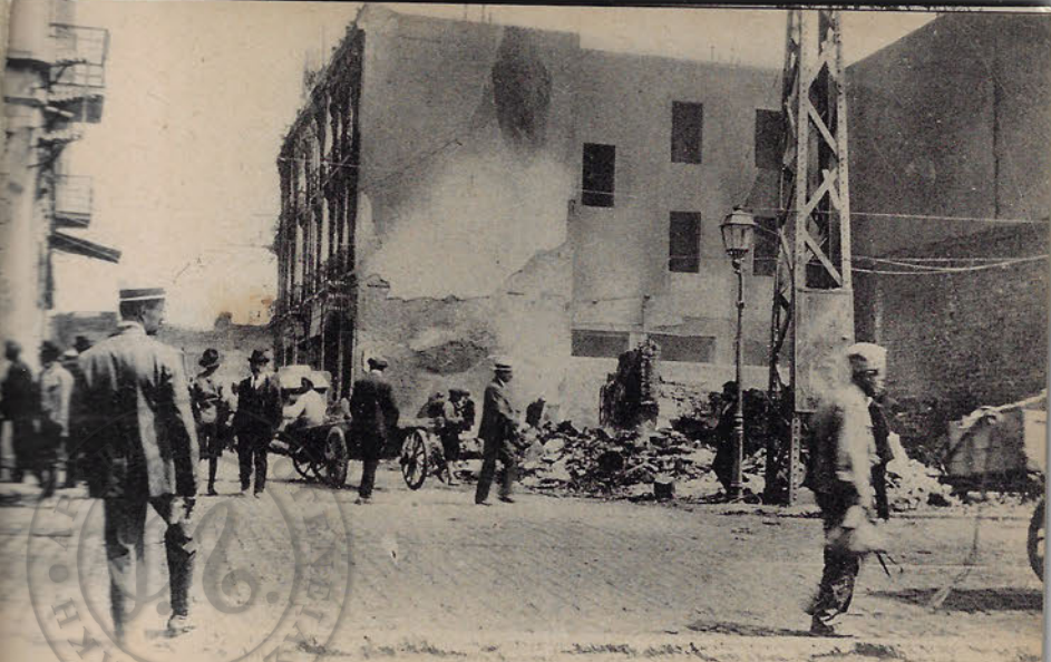
Salonique — Incendie des 18-19-20 Août 1917 - Restes de l'Hôtel des Postes et Télégraphes Salonica — Fire of 18-19-20 August 1917 - Remainder of General Post Office
